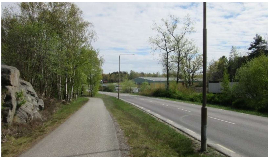
Gång- och cykelväg längs Bulyckevägen. Foto: Norconsult
